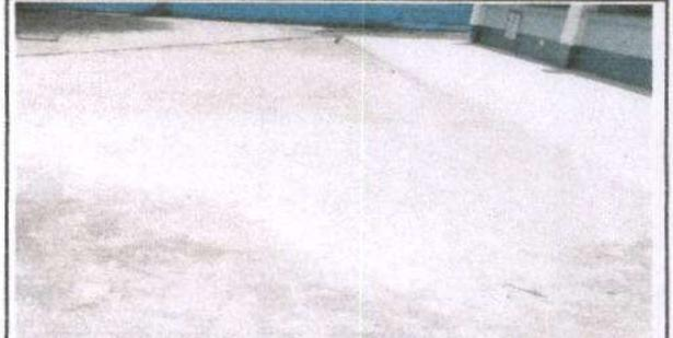
Foto 4: Reparación de planchas de concreto de patio ( T.O. 10 CM.)
