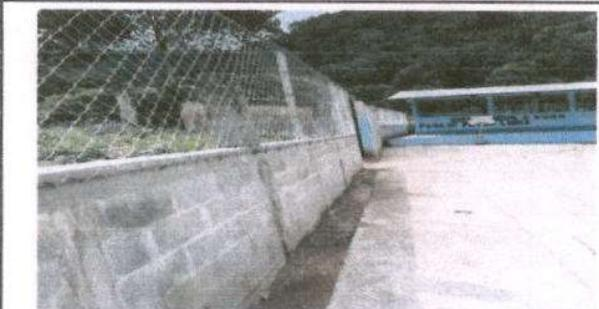
Foto 5: Reparación de muro perimetral de block. Reparación de tubo hg y malla galvanizada
